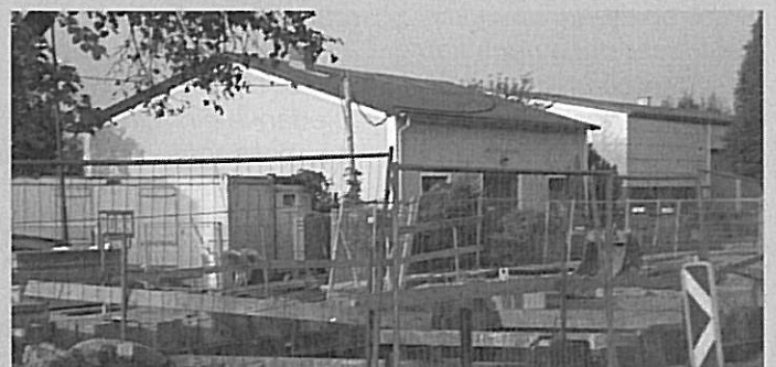
Kanalbau in der Austrasse
